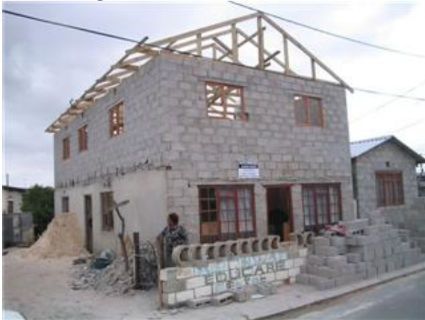
Foto genomen tijdens de bouw van de extra verdieping
